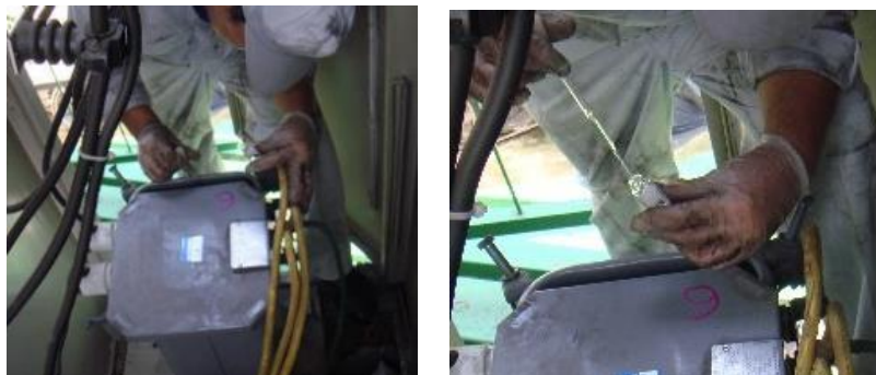
採取口がない変圧器からの絶縁油の採取 (上蓋をずらしてピペットで採取)
