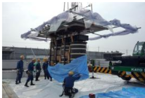
コアが上蓋に取り付けられたもの (養生された床面上に吊り下げ)
