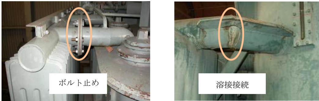
図 8 . 放熱器と筐体との接続例
