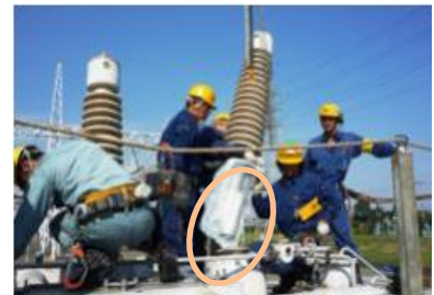
図 9 . ブッシングの養生例
