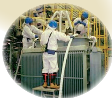
■防護服着用による処理作業
