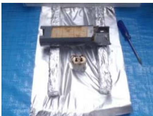
コンデンサ取り外し作業終了
