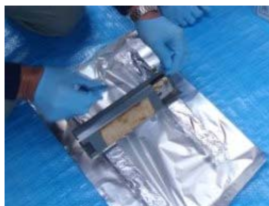
コンデンサ取り外し作業中
